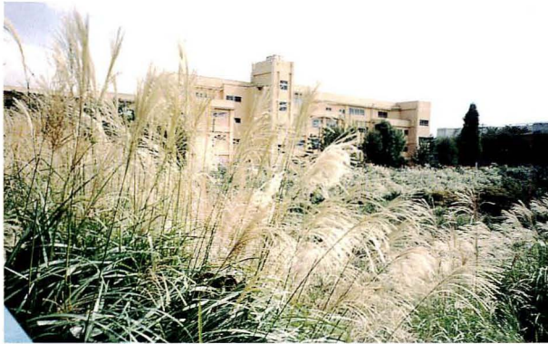
本町田・木曽団地の調整池。 向こうに見えるのは緑が丘小学校
