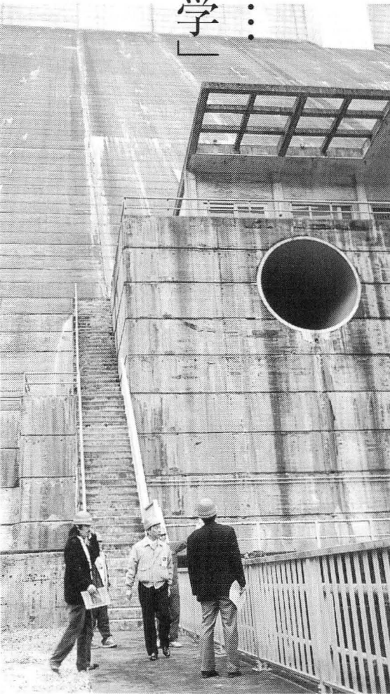
巨大なダムを下からのアングルで…
